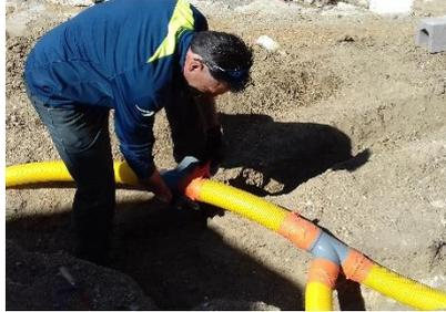
Mise en place du drain et installation de « T » en PVC afin de raccorder les drains perpendiculaires afin de capter le maximum d'eau.
