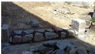
Dans le muret du bas, 3 tuyaux ont été intégrés au niveau de la terre afin de laisser s'écouler l'eau restée en surface.
