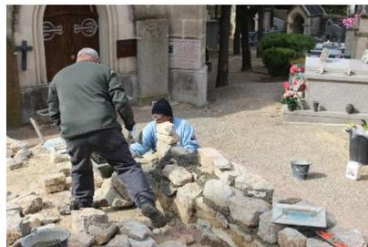
Maçonnage du muret « en escalier » afin de récupérer les niveaux, suivre la pente du terrain et canaliser l'eau.
