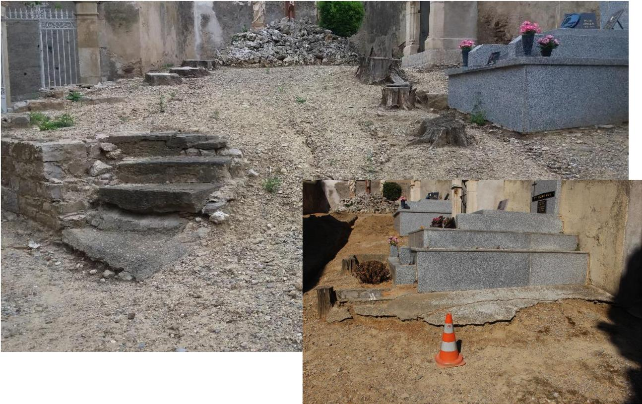
À cause de la configuration et de l'emplacement du cimetière, le ruissellement des eaux de pluie a causé l'érosion du sol et la dégradation des caveaux.
