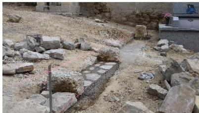
Installation de plusieurs *cordeaux*\* : sur les parties basses et hautes afin de vérifier l'alignement des pierres au fur et à mesure du maçonnage du muret et d'avoir le niveau supérieur du muret.
