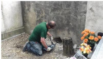
Réalisation de deux trous dans les murs d'enceinte du cimetière sur la partie basse du terrain afin de laisser s'évacuer les eaux de pluie restées en surface.
