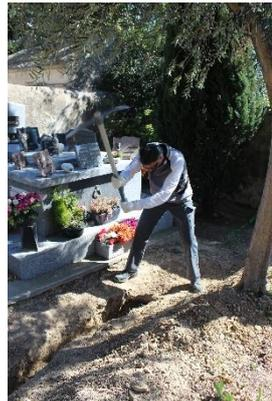
Creusement de la tranchée afin d'implanter le *drain*\*.
