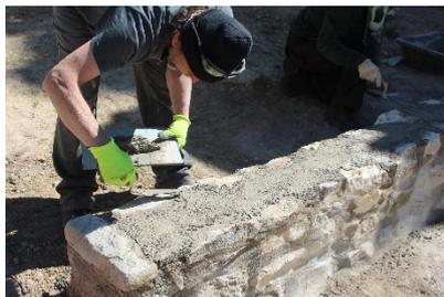
Réalisation des joints à l'aide d'une *taloche\** et d'une *langue de chat\**.
